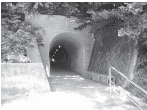
枇杷山トンネル
